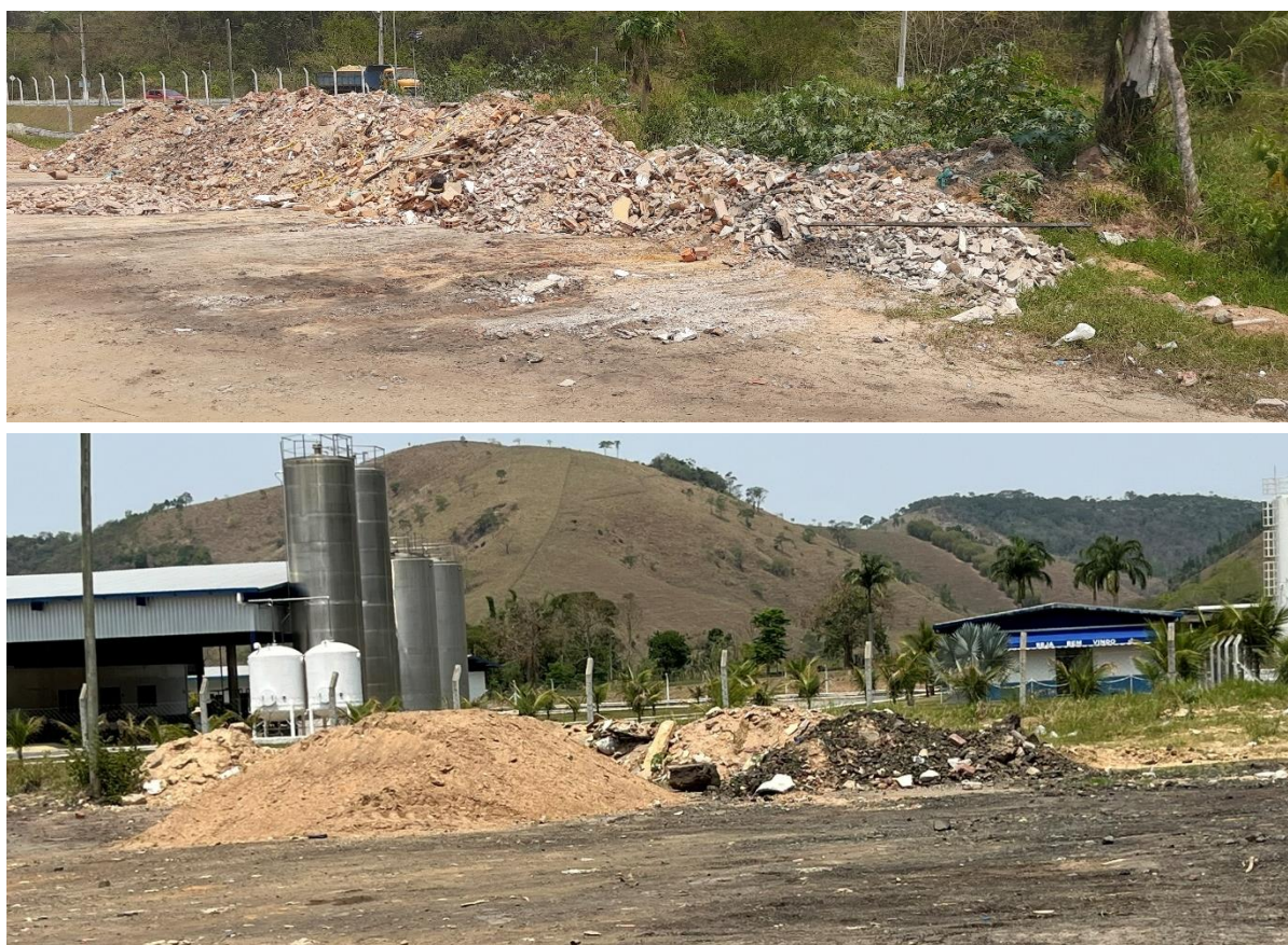
Figura 59: Área de armazenamento temporário dos RCC que podem ser reaproveitados para manutenção de vias.
