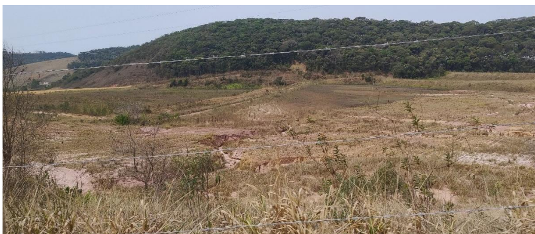
Figura 72: Descaracterização da Barragem de Mercês
