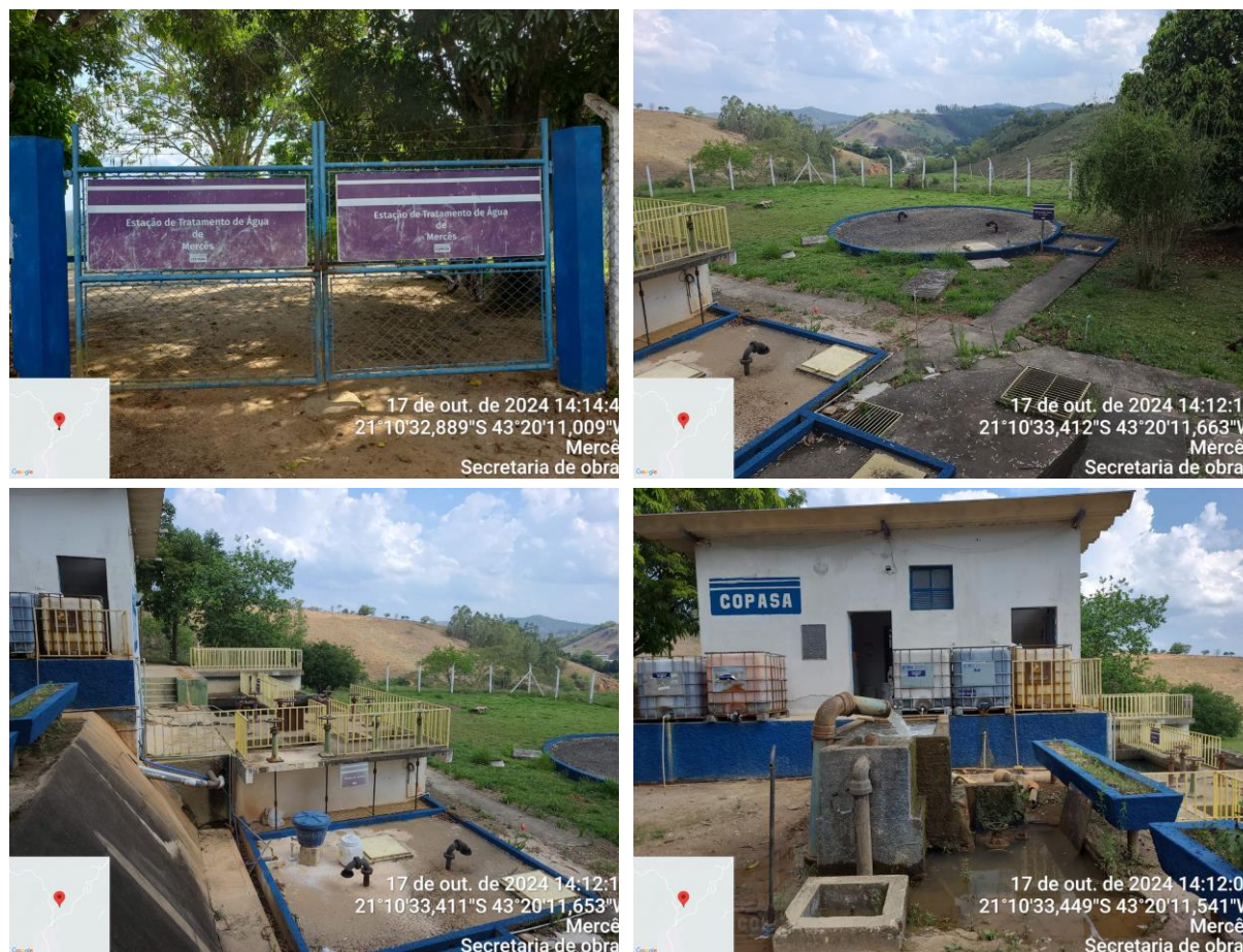
Figura 50: ETA Córrego das Flores.
